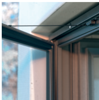
Türschließer, Schließgeschwindigkeit regulierbar
